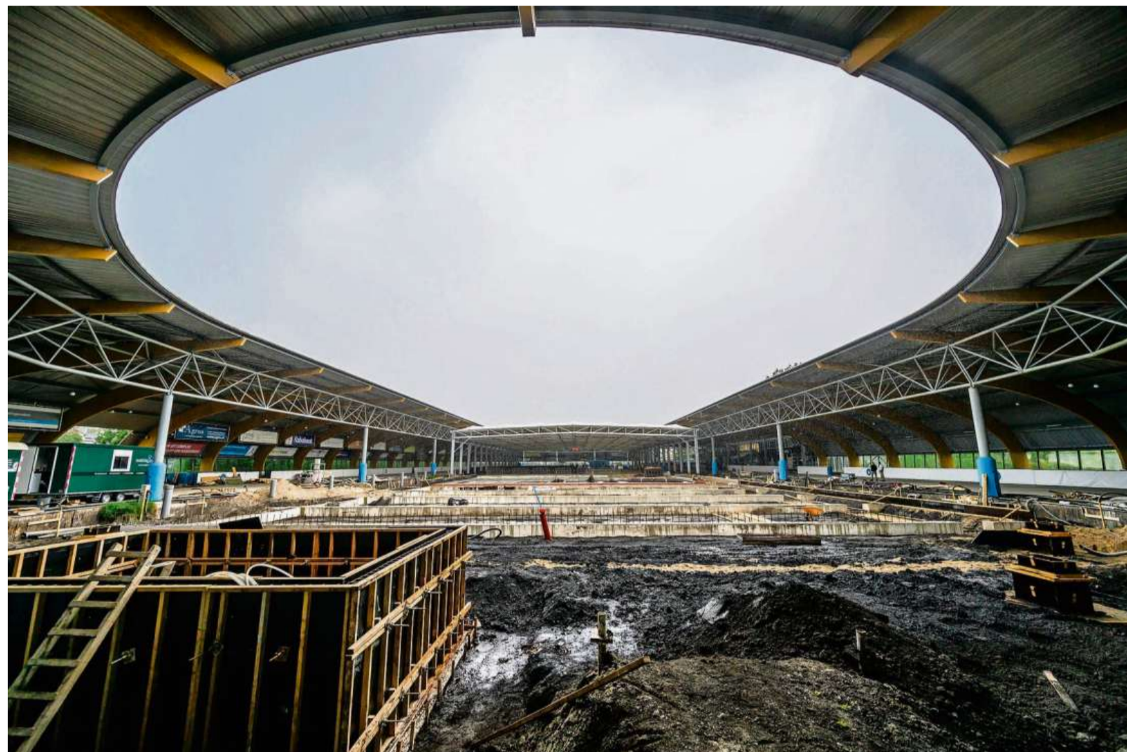
De verbouwing van de ijsbaan.
